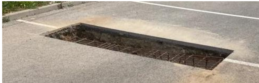
Semelle renforcée (+ ancrages)
